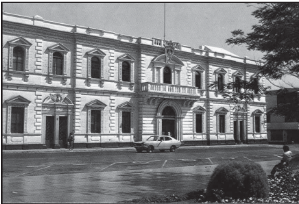
Frontis de la Municipalidad Provincial de Trujillo
