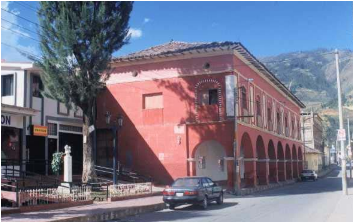
Frontis de la Municipalidad Provincial de Abancay
